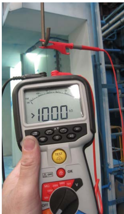
Mesure de continuité de terre sous 500V.
